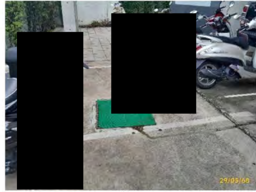
การตรวจสอบบ่อกักน้ำและตะแกรงดักมูลฝอย
