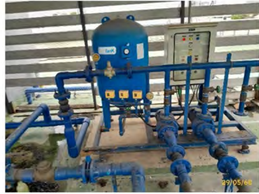
เครื่องสูบน้ำใช้ และปั้มน้ำเสริมแรงดัน
