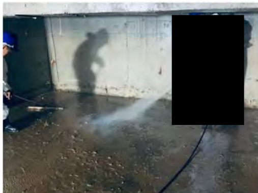
การทำความสะอาดถังเก็บน้ำสำรอง
