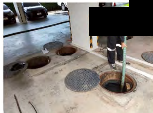
การสูบน้ำออกจากระบบบำบัดน้ำเสีย
