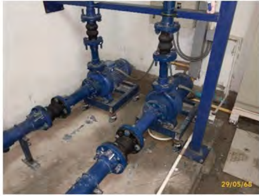
เครื่องสูบน้ำใช้ และปั้มน้ำเสริมแรงดัน
